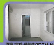
洋室/完成・通気性クロス仕上げ
