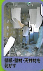
壁紙・壁材・天井材を剥がす
