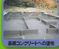
基礎コンクリートへの塗布
