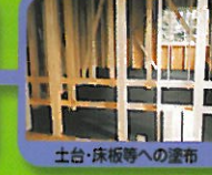
土台・床板等への塗布
